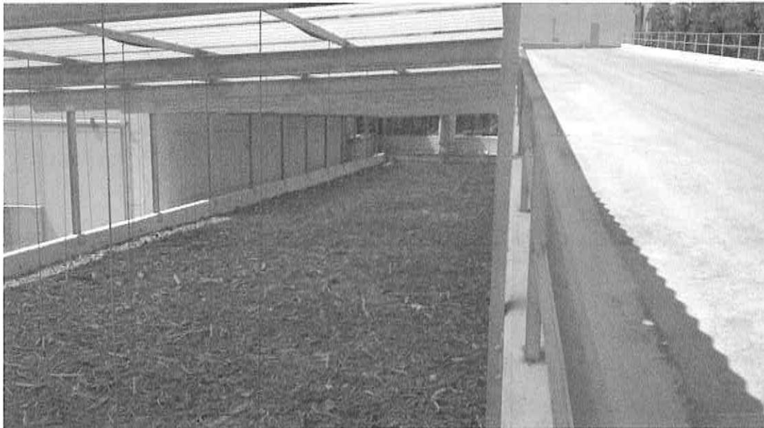
***Letto del biofiltro visto dall'alto (si notano i sistemi di umidificazione dello stesso (tubi posti verticalmente sul materiale filtrante)***
