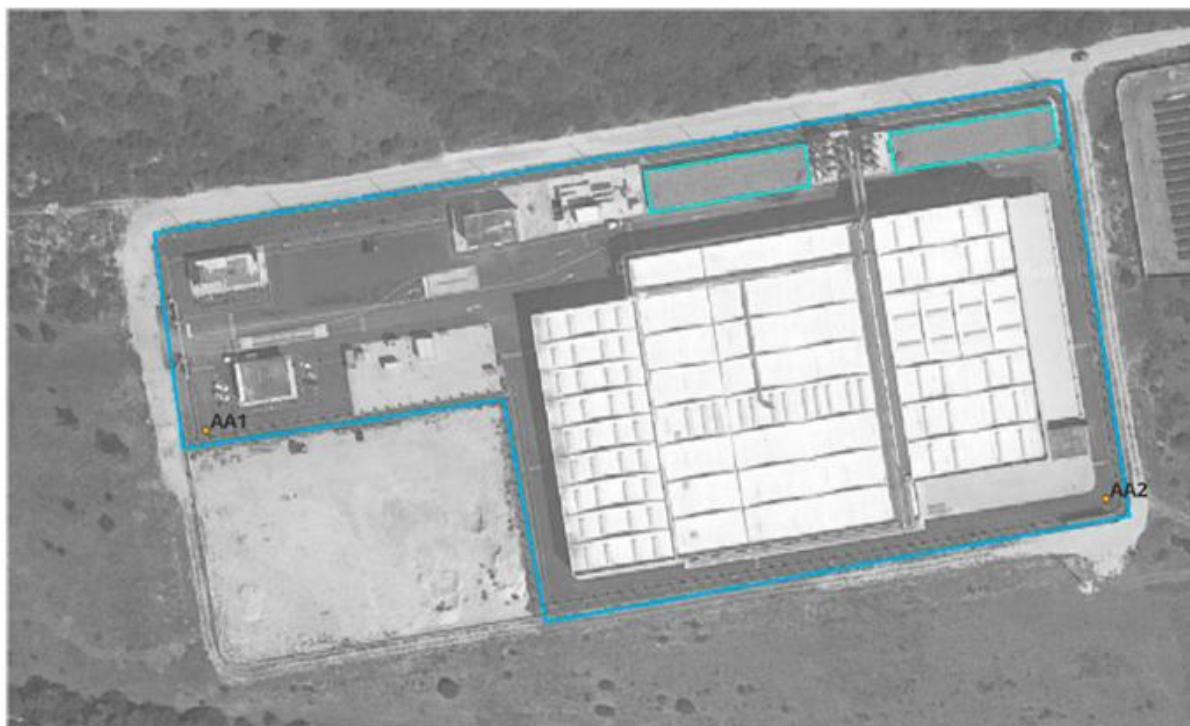
Figura 2. Posizioni perimetrali di monitoraggio.
