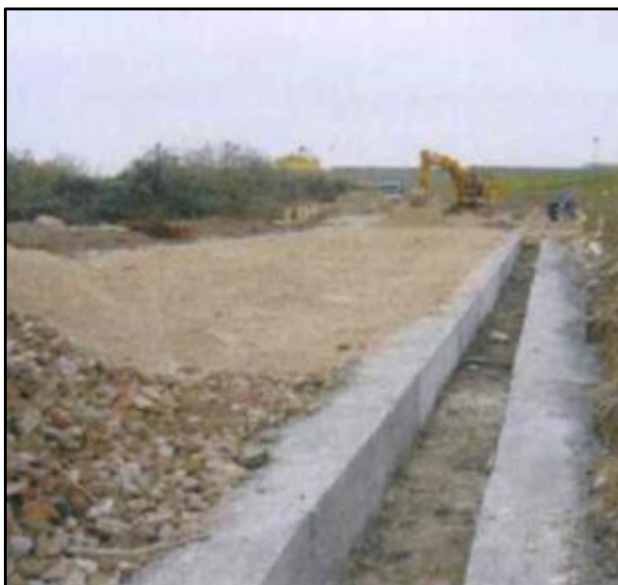
Figura 8.4.3 – Realizzazione delle corree in calcestruzzo.
