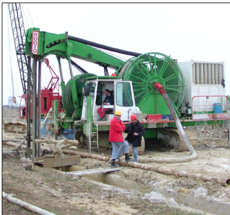
Figura 4 – Scavo con idrofresa.
