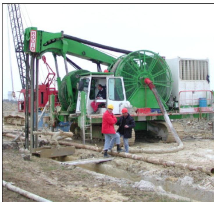
Figura 8.4.5 – Scavo con idrofresa.
