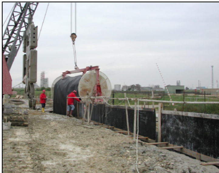
Figura 8.4.6 – Messa in opera del telo HDPE.
