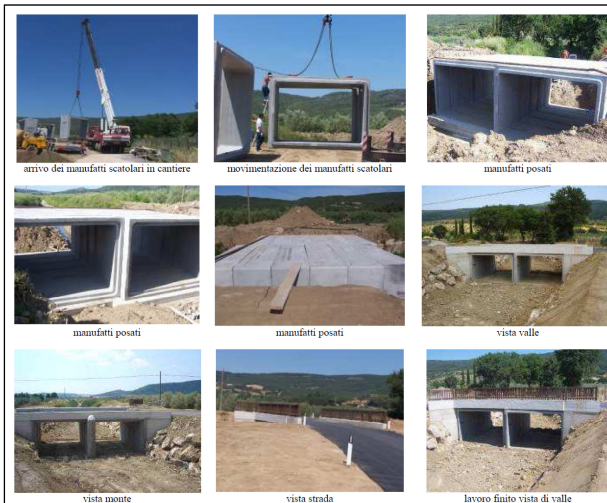
Figura 8.1.6 – Esempio di realizzazione di un attraversamento stradale con scatolari in c.a.
