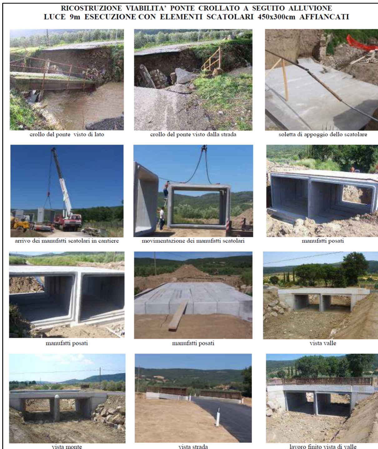
Figura 5.1.3 c – Esempio di realizzazione di un attraversamento stradale con scatolari in c.a..
