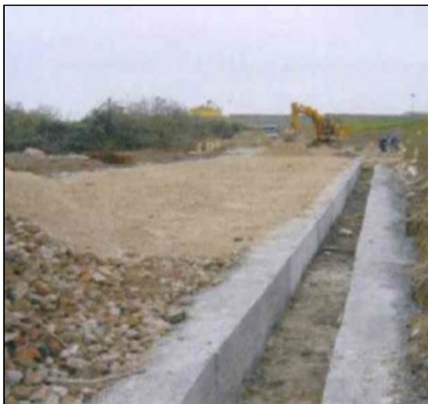
Figura 2 – Coppia di corree di guida in calcestruzzo.
