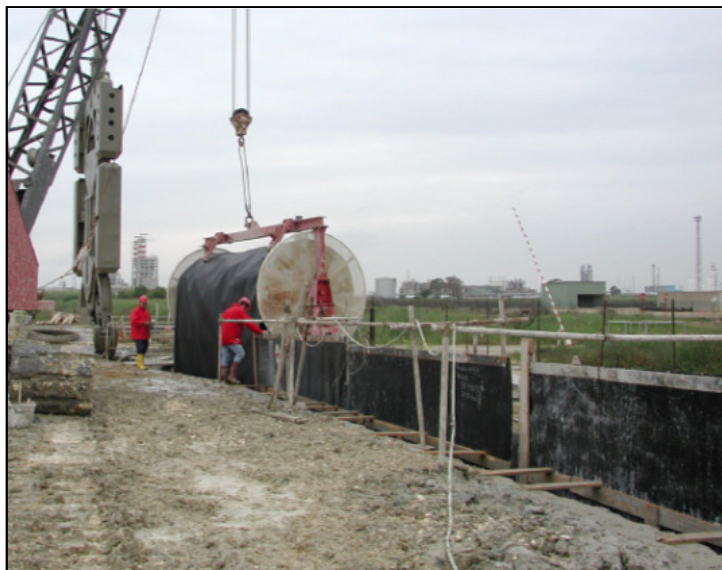
Figura 5 – Messa in opera del telo HDPE [1].
